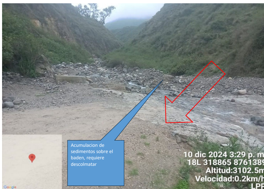
FIGURA N°03: EN LA TEMPORADA DE MAXIMAS AVENIDAS, LA QUEBRADA RAVIRA SE SEDIMENTA Y REALIZA DESVIO DE AGUAS OCACIONANDO, DETERIORO DE LA CARRETERA.
